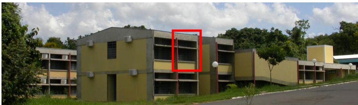
Figura 2 – Prédios estudados; em primeiro plano a fachada NNE do DESIGN, com destaque para a sala simulada; em segundo plano o prédio do DAUP.
