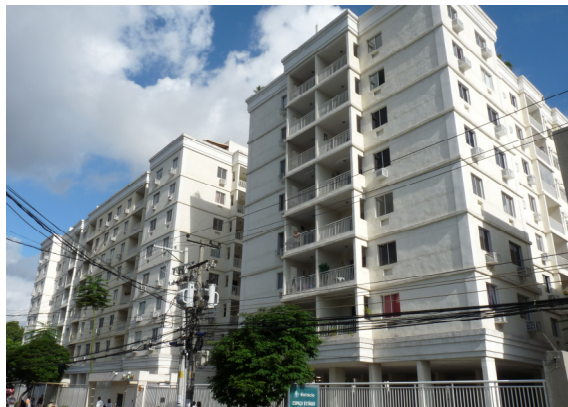
Figura 3 – Duas das edificações testadas Fonte: própria
