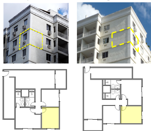
Figura 5 – Duas UHs em prédios de mesma configuração de pavimento tipo, posicionados com orientações diferentes um em relação ao outro. Notar os APPs nas extremidades; apesar de possuírem duas possibilidades de abertura, a Aab de cada um seguiu o padrão do projeto e não o que poderia ser a melhor orientação. Fonte: elaboração própria
