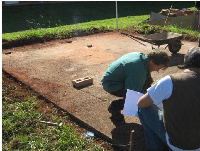
Figura 1 – Lastro de concreto simples (base das células-teste).
