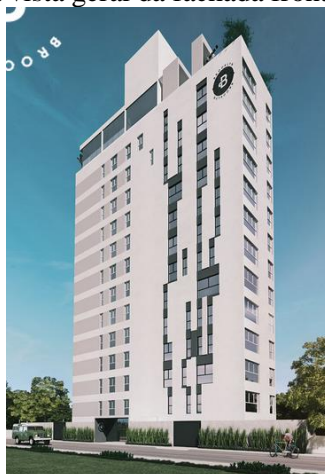
Figura 2- Fachada frontal noroeste
