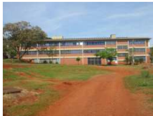
Figura 6 – Fachada noroeste do bloco D67.
