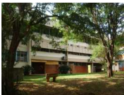
Figura 2 – Fachada sudoeste do bloco C67.
