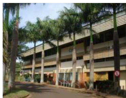
Figura 3 – Fachada nordeste do bloco C67.
