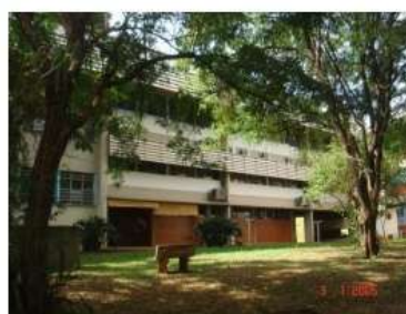
Figura 3: Fachada Sudoeste do bloco C67.
