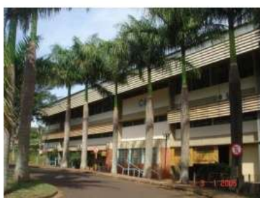
Figura 2: Fachada Nordeste do bloco C67.
