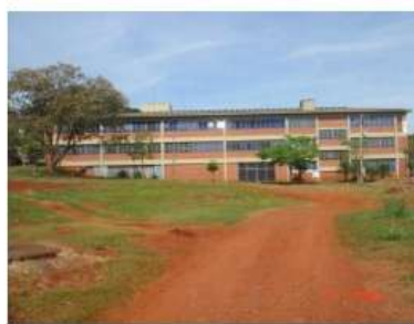
Figura 5: Fachada Noroeste do bloco D67.
