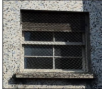
Figura 5 – Janela de dormitórios
