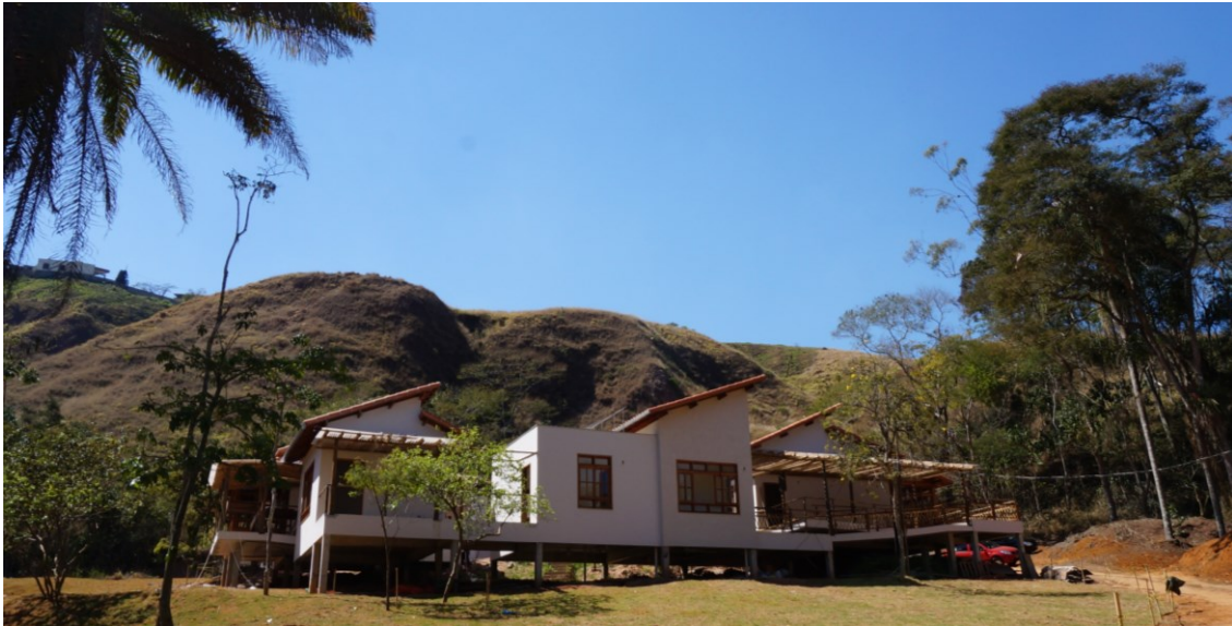
Figura 1- Fotografia da edificação em fase final de obras. Fonte: Acervo dos autores
