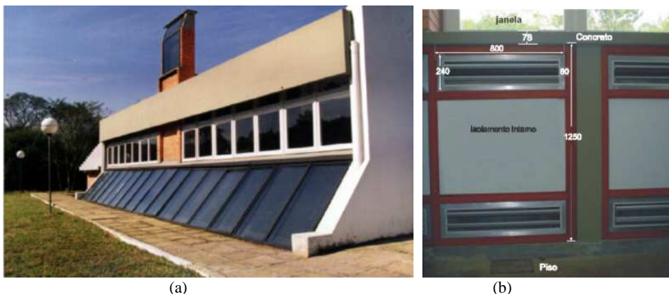
Figura 1 - Parede Trombe do Laboratório de Energia Solar da UFRGS (a) Vista externa e (b) Interna.
