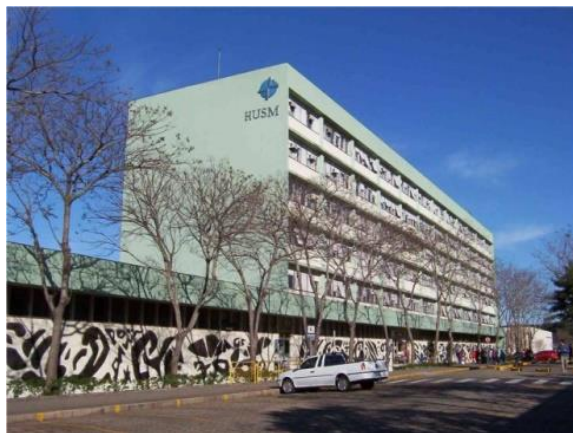
Figura 1- HUSM: fachada oeste
