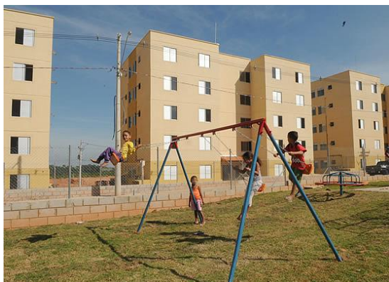
Fig.1.1 Exemplo de blocos de apartamentos de 5 andares sem elevador do PMCMV (Fonte:
