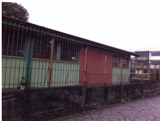
Figura 1 - Fachada da Escola Estadual Dante Marcucci.
