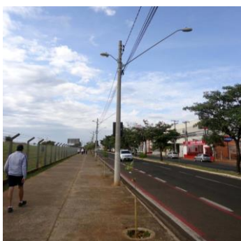
Figura 9 - Poste de iluminação pública
