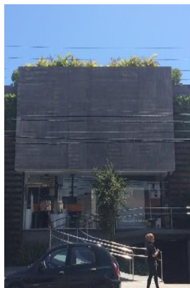
Figura 2 – Fachada principal do edifício.
