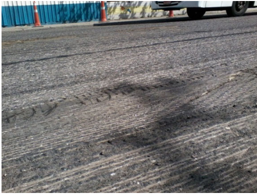
Figura 2 – Vista da pista fresada a partir do ponto de medição 1
