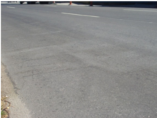
Figura 5 – Vista do pavimento após o recapeamento no trecho fresado
