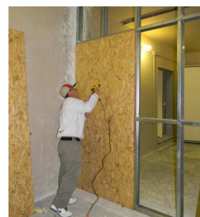
Figura 5 - Revestimento do painel estrutural utilizando painéis OSB.
