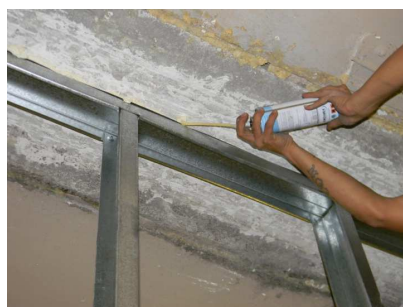
Figura 4 - Vedação do painel ao vão da câmara com espuma expansiva de poliuretano.
