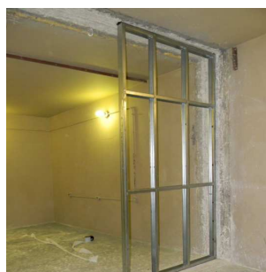
Figura 3 - Painel estrutural de aço galvanizado fixado no vão da câmara.
