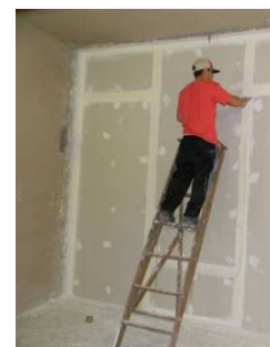
Figura 9 - Tratamento de juntas nas placas de gesso acartonado.
