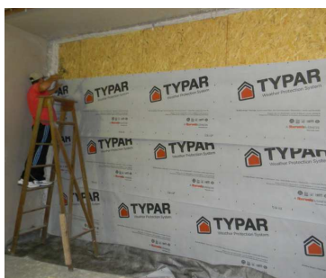
Figura 6 - Instalação da membrana hidrófuga sobre os painéis OSB.
