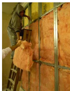
Figura 7 - Instalação da lã de vidro.
