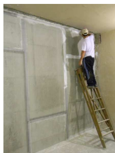
Figura 8 - Tratamento de juntas nas placas cimentícias.
