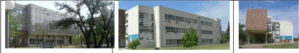
Figura 1 - Vistas Norte, Sur y Oeste. Facultad de Lenguas. UNC.
