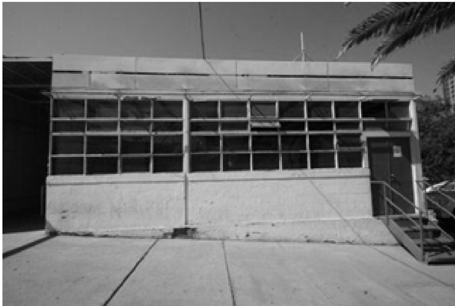
Figura 1 – Fachada norte de la sala D101 seleccionada para reacondicionamiento
