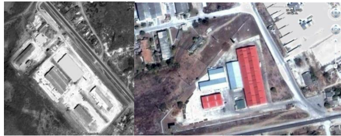
Fig.-2 Vista aérea de Almacenes Universales SA, (AUSA), institución o empresa en que se realizó un estudio de la iluminación natural en relación con la eficiencia y ahorro de portadores energéticos.
