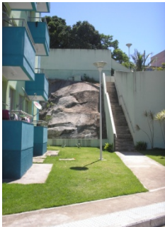
Figura 9 – Maciço Rochoso e escadaria de acesso à parte superior do terreno.
