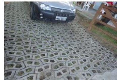
Figuras 6, 7 e 8 – Casos onde a área de preenchimento não apresenta boas condições, diferentemente do bloco de concreto. Fonte: Levantamento da equipe, 2013.
