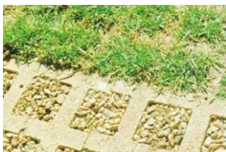
Figura 1 - Tipos de preenchimentos para cobograma: pedrisco e gramínea. Disponível: http://www.rhinopisos.com.br/site/pisograma/ Acesso em: 20/02/2013.
