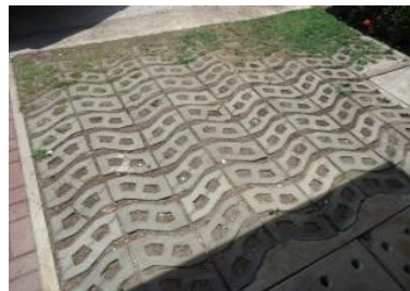
Figuras 6, 7 e 8 – Casos onde a área de preenchimento não apresenta boas condições, diferentemente do bloco de concreto. Fonte: Levantamento da equipe, 2013.
