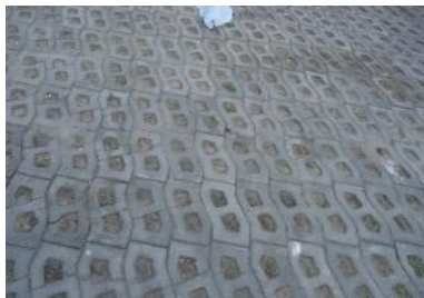
Figuras 6, 7 e 8 – Casos onde a área de preenchimento não apresenta boas condições, diferentemente do bloco de concreto. Fonte: Levantamento da equipe, 2013.
