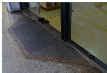
Figura 3 – Inserção de rampa no acesso à loja, junto ao Terminal de Embarque do Aeroporto de Confins, permite que pessoa em cadeira de rodas frequente o interior da loja – Belo Horizonte/MG (acervo próprio)
