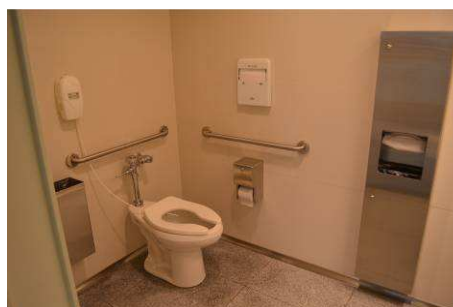
Figura 2 – Sanitário adaptado possibilita o uso por todas as pessoas, independente de suas habilidades ou restrições. Aeroporto de Montevidéu. (acervo próprio)
