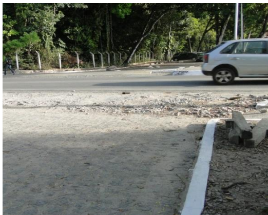
Figura 8 – Estacionamento (A) circulação e vaga de veículos com piso irregular, (B) Circulação de pedestre obstruída.
