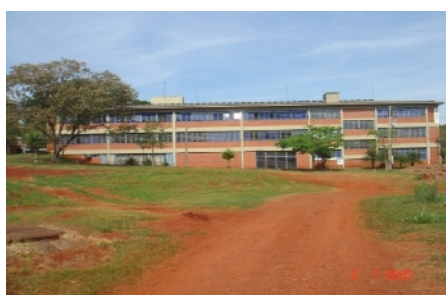
Figura 5: Fachada Noroeste do bloco D67
