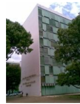
Figura 3 – Vista da fachada oeste e empena norte.
