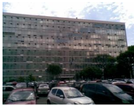
Figura 2 – Vista da fachada leste do MPS/MTE.
