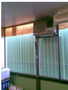
Figura 7 – Fixação de papel no vidro para proteção da iluminação.
