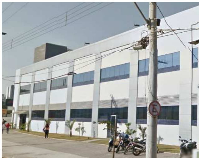
Figura 1 - Imagem do edifício construído
