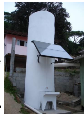
Figura 17 - Protótipo da torre em ferrocimento artesanal
