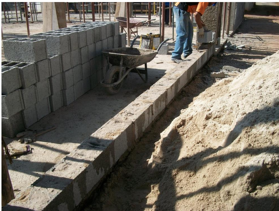
Figura 2 - Foto da execução da primeira fiada da alvenaria e o enchimento das câmaras dos blocos de concreto com areia
