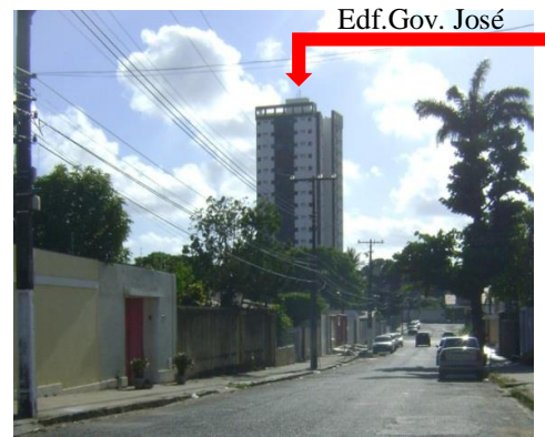
Foto 02- Entono do Edifício Governador José Tavares, Farol - Maceió - AL. Fonte: acervo autor.
