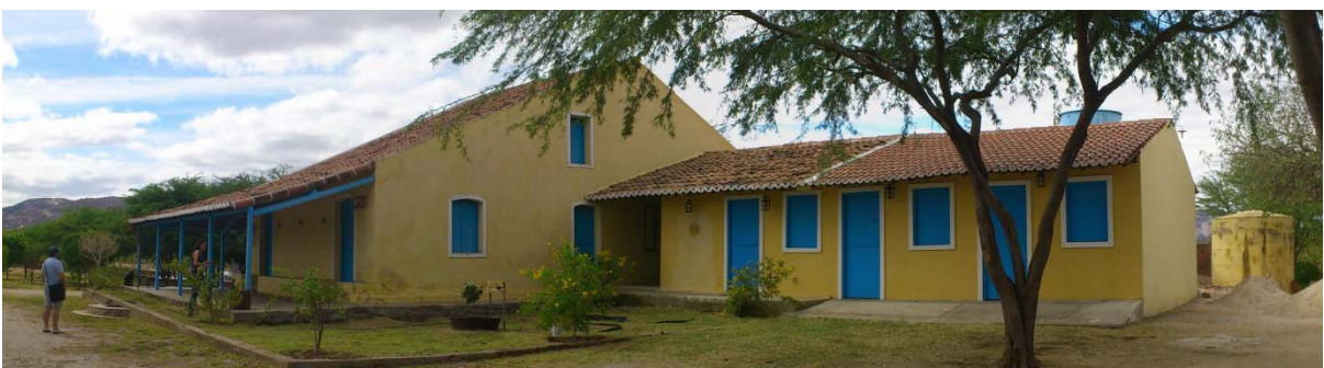
Figura 12. Fachada Oeste da casa principal.
