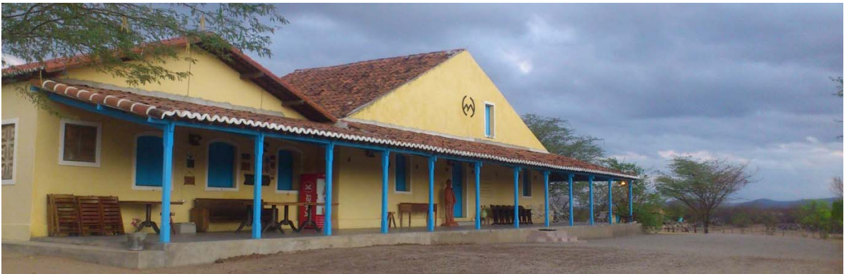
Figura 11. Fachada Leste da casa principal.
