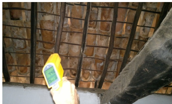
Figura 16 - Conjunto de telhas permeável ao vento
