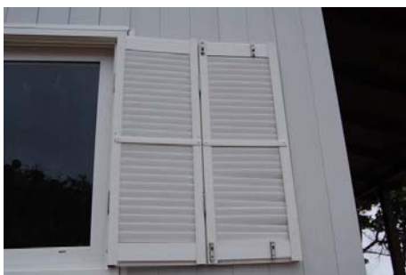
Figura 11. Janela tipo 01. Fonte: acervo LPP/Ufes.
