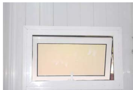
Figura 13. Janela tipo 03 Fonte: acervo LPP/Ufes.
