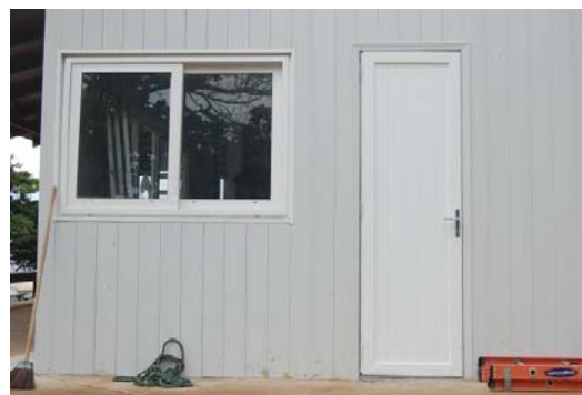
Figura 10. Porta tipo 02 e janela tipo 01 sem veneziana Fonte: acervo LPP/Ufes.
