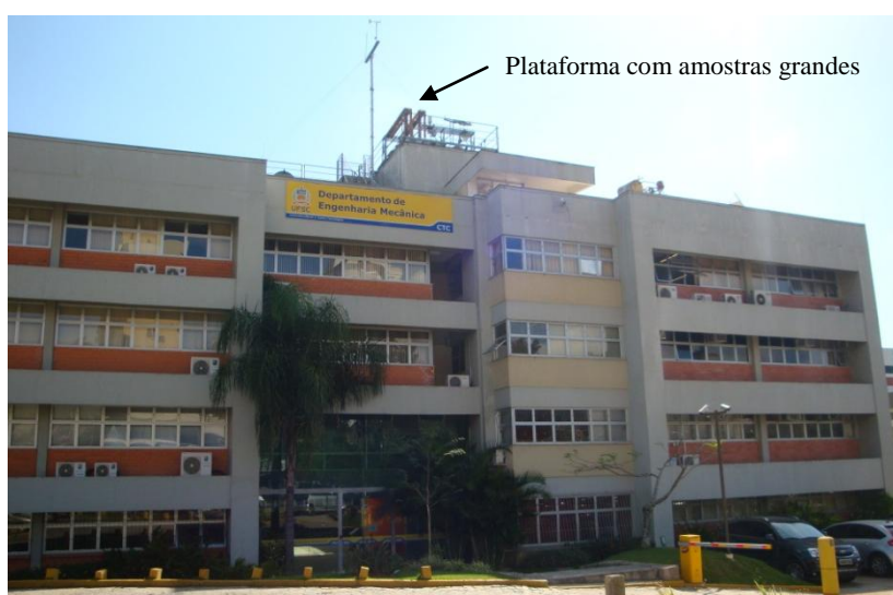
Figura 3 – Plataforma posicionada na cobertura de prédio da UFSC.
