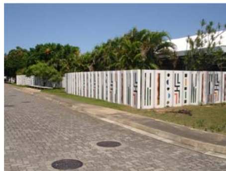
Figura 9 – Fachada da sala de espera (Acervo da autora, 2009)
