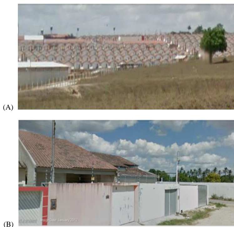
Figura 4: Residencial Brisa do Lago, localizado no bairro Olho D'água dos Cazuzinhos, Zona de Ocupação Dirigida - o conjunto ocupa uma área de 70 hectares (A); b) Ocupação de novos loteamentos no bairro Capiatã, Zona de Qualificação Urbana - predomínio de edificações sem recuos laterais, pequenos recuos frontais (B).
