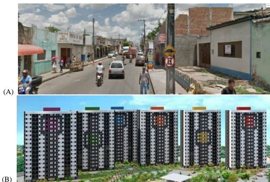
Figura 5: Padrões construtivos predominantes nas Zonas de Qualificação Urbana (A), b) Novos padrões construtivos na Zona Institucional -torres de 16 pavimentos (B).
