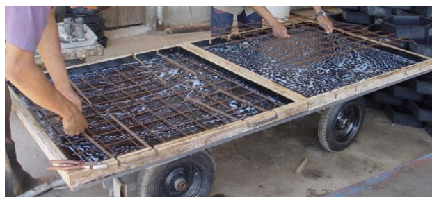
Figura 3 – Ferragem das placas de contrapiso.
