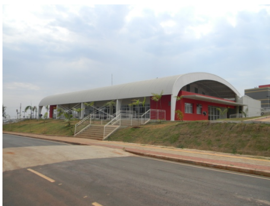
Figura 5. Vista das fachadas frontal e lateral.
