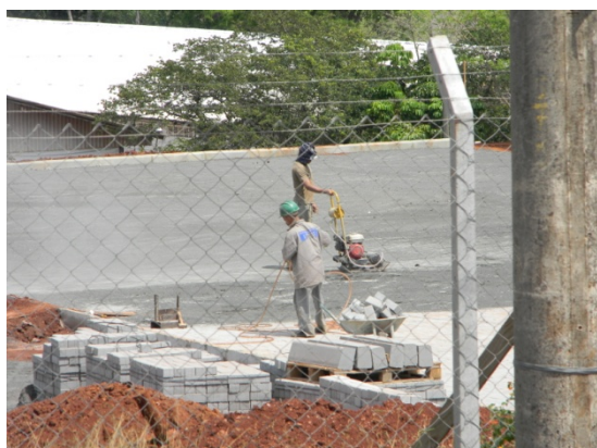
Figura 3. Maquinário em operação em edificação vizinha ao RUSB.
