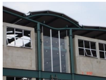
Figura 2 - Edifício com fechamento em blocos de concreto e esquadrias de alumínio e vidro.
