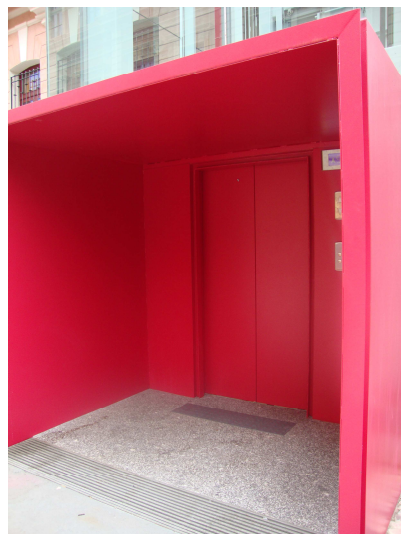
Figura 6 – Acesso externo ao edifício por meio de elevador.
