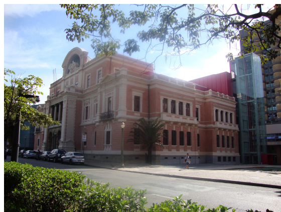
Figura 2 - Edifício após reabilitação
