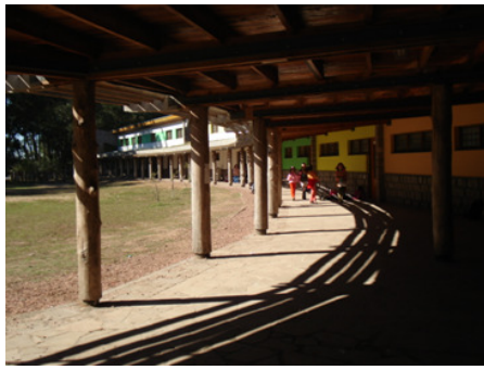
Figura 3- Circulação coberta na fachada norte
