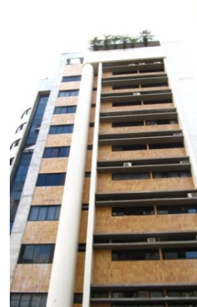
Figura 2 – Fachada norte do edifício. Fonte: autora
