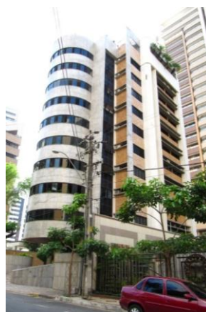
Figura 1 – Fachada leste do edifício. Fonte: autora
