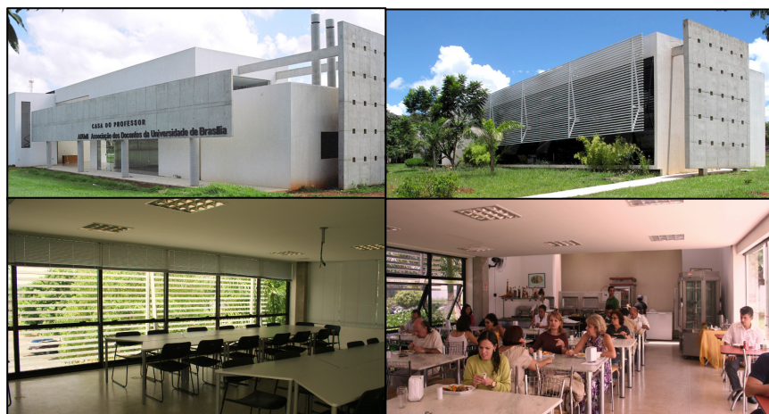
Figura 1 – Edifício da Casa do Professor na Universidade de Brasília. No sentido horário, começando da esquerda superior: fachada Oeste, fachada Leste, Restaurante e Sala de Reuniões.
