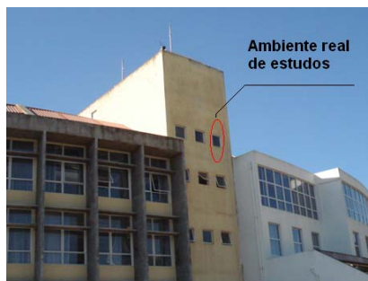
Figura 2 - Localização do ambiente real e o arranjo de suas janelas orientadas para o Sul
