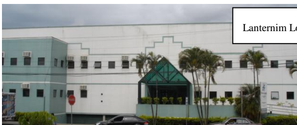
(a) Fachada Antiga Policlínica
