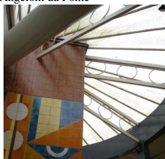
(c) Cobertura envidraçada
