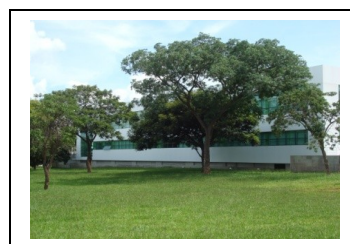
Foto 3 – Fachada nordeste do Bloco Educacional
