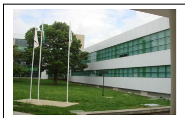
Foto 2 – Fachada sudoeste do Bloco Educacional
