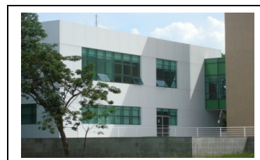
Foto 4 – Fachada noroeste do Bloco Educacional
