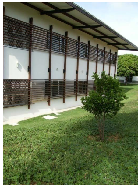
Figura 6 - Proteções solares nas fachadas Sul.
