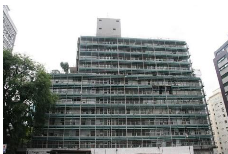
Figura 1 – Fachada noroeste do edifício. Fonte: Foto de Fernando Pasquali
