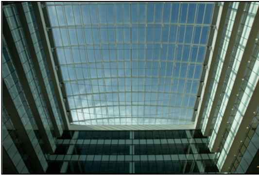
Figura 3: Detalhe clarabóia do átrio Fonte: Fornecida pela Ruy Rezende Arquitetura
