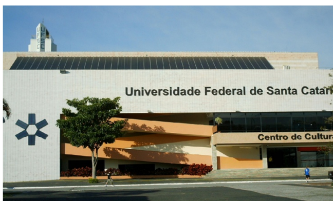
Figura 1 - Sistema fotovoltaico plano inclinado a 27°N, com 10,24 kWp, integrado ao Centro de Cultura e Eventos da UFSC.
