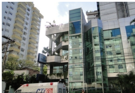
Figura 7 – HON: Fachada Sul Fonte: LabCECA UFF
