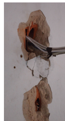
Figura 5 – Paredes constituída de tijolo cerâmico
