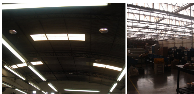
Figura 2 - Cobertura metálica semi-circular (empresa I) e em shed (empresa III), respectivamente
