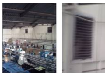
Figura 7: Resfriamento evaporativo na empresa IV
